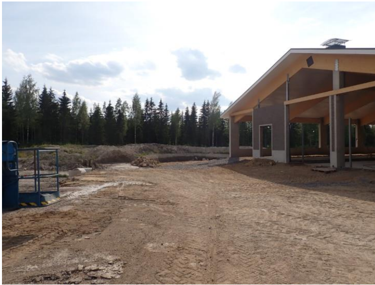
Kuva 3-20 Rakenteilla oleva pihattorakennus, jonka kohdalle AM-alue on tarkoitus ulottaa (Poutiainen, H. 2021)
