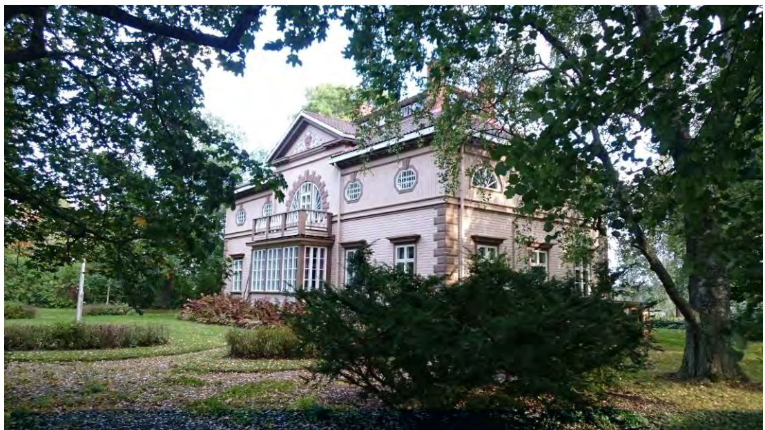
Kuva 9. Rapalan kartanon päärakennus sisäpihan puolelta kuvattuna.
