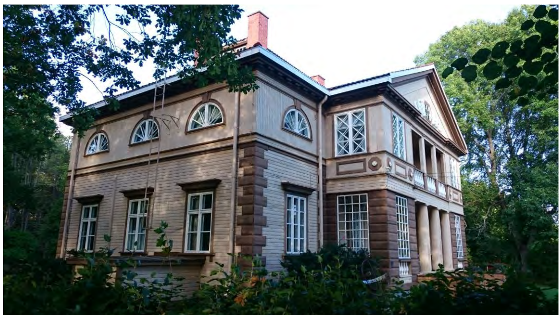
Kuva 10. Rapalan kartanon päärakennus Rapalanlammen puolelta kuvattuna.
