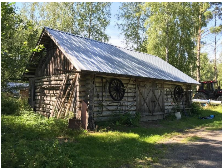
Kuva 3-26 Kaavamuutoskohteessa sijaitsevia rakennuksia.
