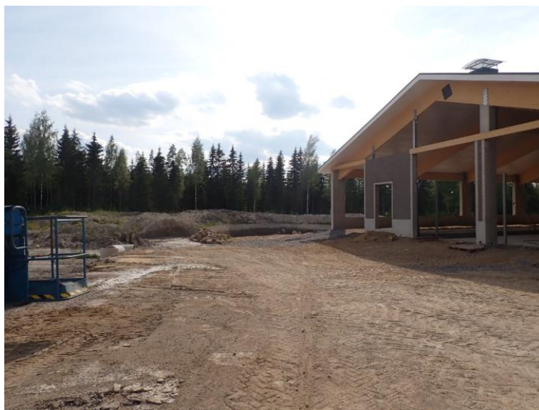
Kuva 3-22 Rakenteilla oleva pihattorakennus, jonka kohdalle AM-alue on tarkoitus ulottaa (Poutiainen, H. 2021)
